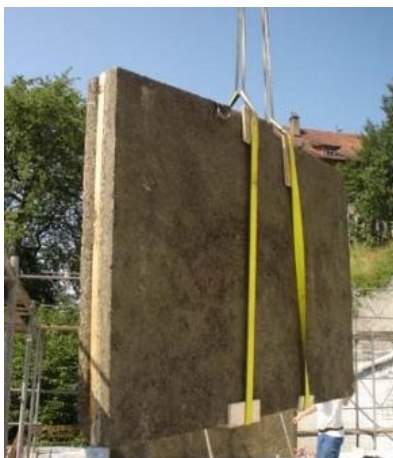
Fig. 16.1. Miscanthus folosit la obținerea panourilor prefabricate
