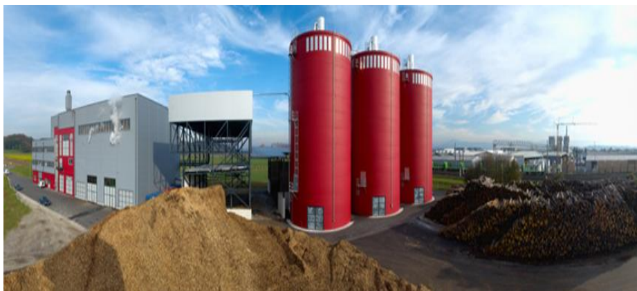
Fig. 16.5. Centrala energetică BIOMASSE – HEIZKRAFTWERK
